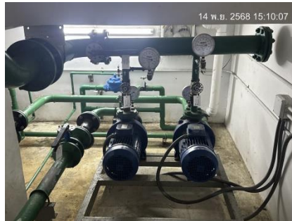
ถังเก็บน้ำใต้ดินและระบบปั้มน้ำใช้ อาคาร A
