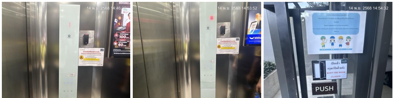
ระบบคีย์การ์ด (Key Card) ภายในอาคารโครงการ
